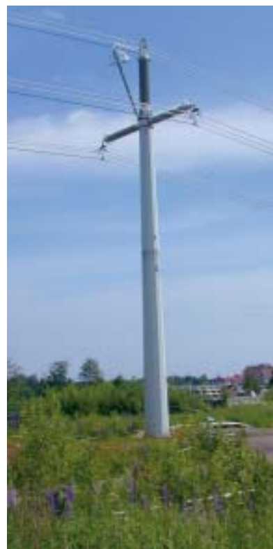
Kompaktstolpen har tre faser som är placerade tätt ihop i en triangel. Det gör att magnetfältet minskar betydligt. Ledningen på bilden är en provledning som byggts på STRI:s område i Ludvika.
