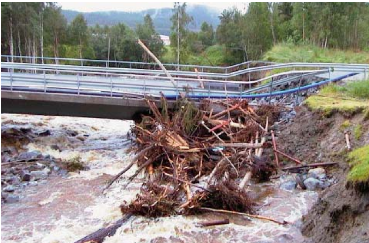
Skadad bro över den oreglerade Granån vid Ljungaverk.
