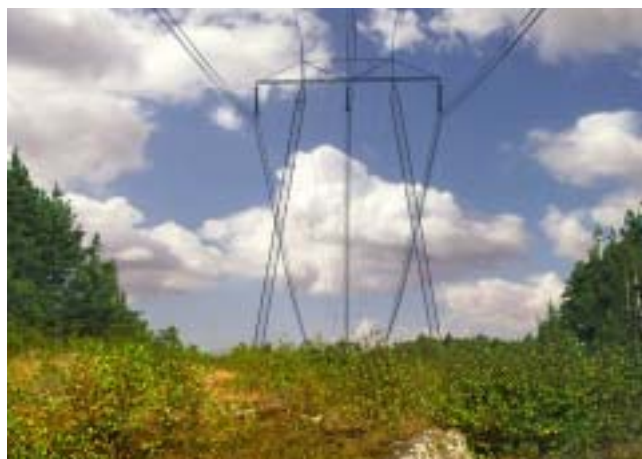
Den största delen av nya 400 kV ledningen kommer att byggas med s.k. portalstolpar, som har en höjd av ca 35 m. Avståndet mellan dessa stolpar är ca 400 m.
