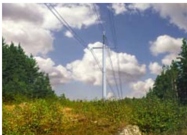
Vid trånga passager och bebyggelse kan 400 kV ledningen komma att byggas med s.k. kompaktstolpar eller designstolpar. Dessa har en höjd av ca 30 m och ett avstånd på ca 250 m mellan stolparna. Exempel på kompaktstolpe.
