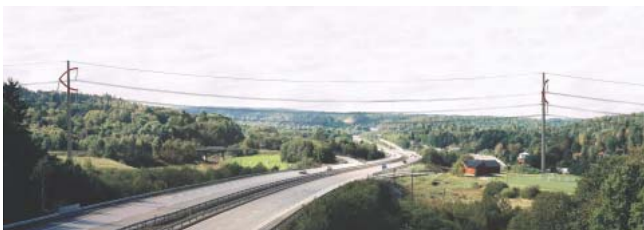
Svenska Kraftnät planerar att bygga en ny 400 kV ledning mellan stationerna Stenkullen och Lindome i Göteborgstrakten. Vid passagen över riksväg 40 är ett alternativt att uppföra ledningen med speciellt formgivna kompaktstolpar, som är väl anpassade till den aktuella miljön (fotomontage med s. k. designstolpar utplacerade i miljön). Se även bilden ovan.
