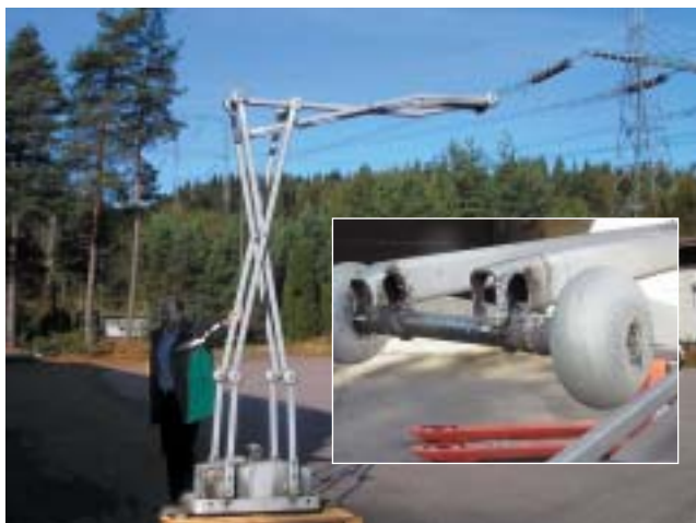
När fränkskiljaren i Horred-stationen havererade uppstod en ljusbåge som kortslöt delar av ställverket. Skadorna på fränkskiljaren visas i detaljbilden.
