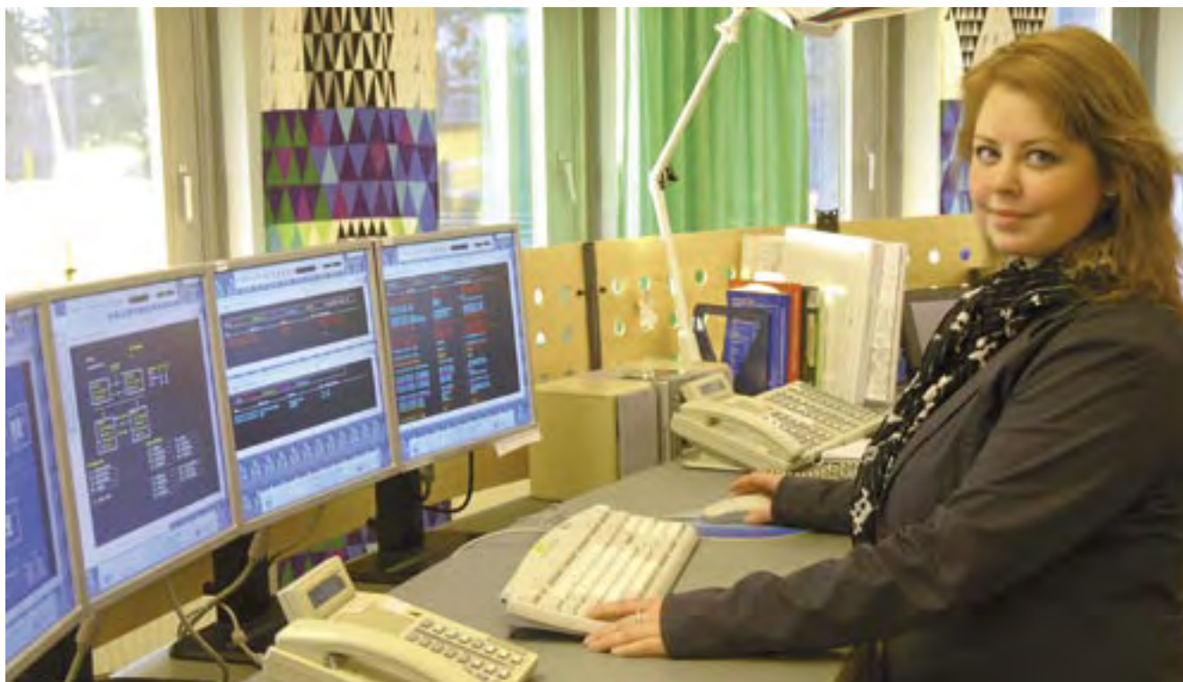
Från Telekontroll övervakar
