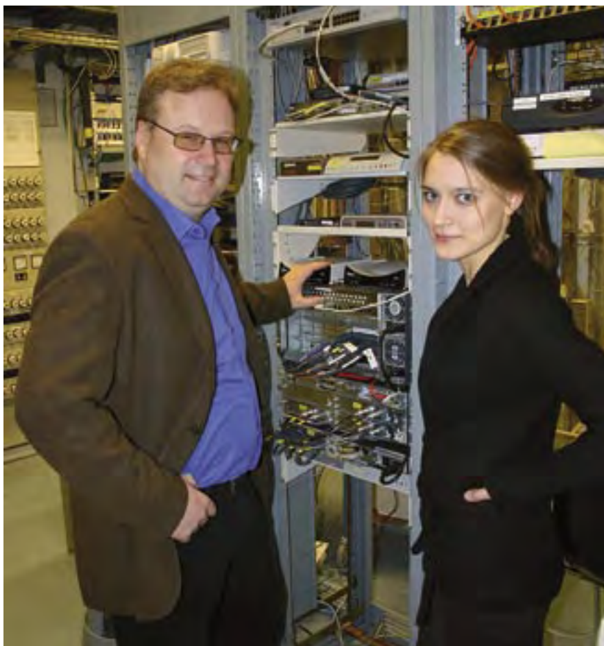
Svenska Kraftnät samarbetar med bland andra Vattenfall Eldistribution när det gäller frågor som rör telekommunikation.
