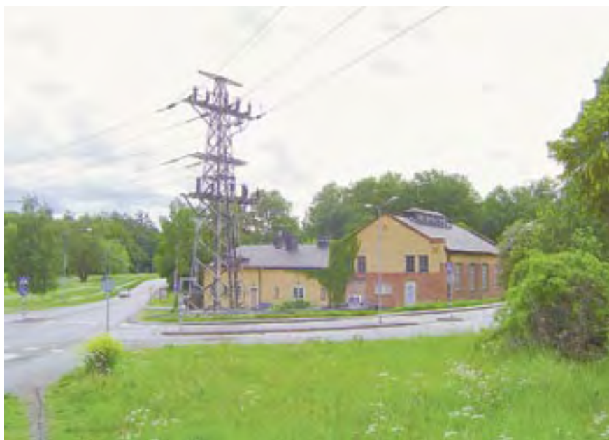
70 kV ledningarna vid Lidingös första kraftstation kommer att ersättas med en nedgrävd 220 kV kabel.
