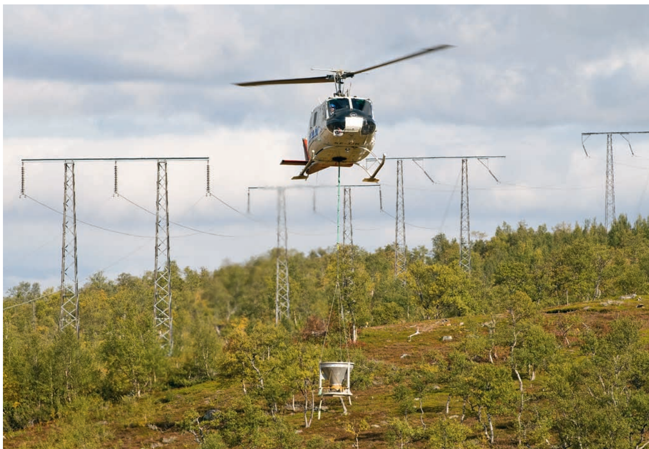
Under senare delen av år 2008 startade arbetet med att bygga den svenska delen av den nya 400 kV ledningen mellan Järpströmmen och Nea. En stor del av materialet flygs in med helikopter.
