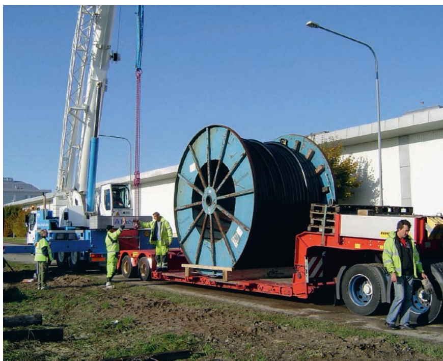
I november 2008 levererades de 220 kV kablar som ska ge en ny inmatning till Uppsala och därmed förstärka matningen till staden.
