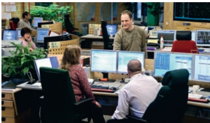
Kontrollrummet i Räcksta är bemannat dygnet runt.
