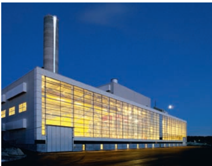
Rya Kraftvärmeverk togs i drift i Göteborg vid årsskiftet 2006/2007. Anläggningen har en kapacitet på 260 MW el och 290 MW värme och är idag den största enskilda förbrukaren av naturgas i Sverige.
